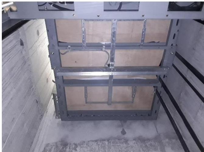
Dessous de cabine
