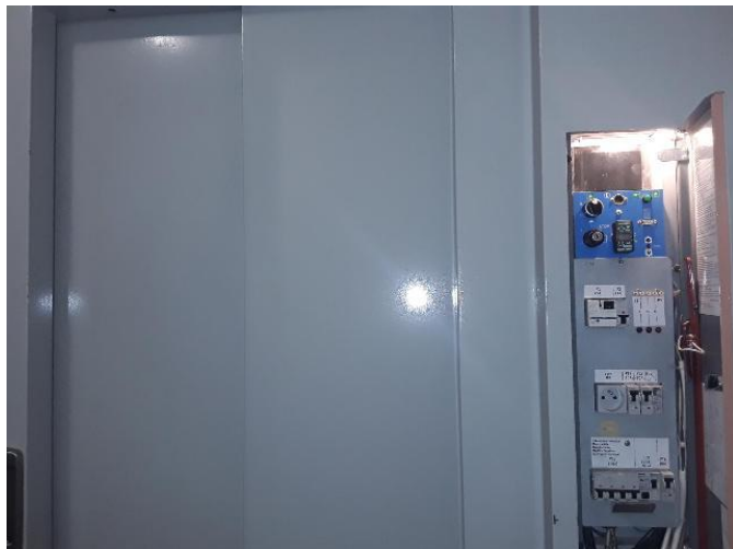
Accès local des machines
